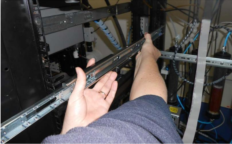
**Figure 70 – Essai de montage des glissières dans le rack**
